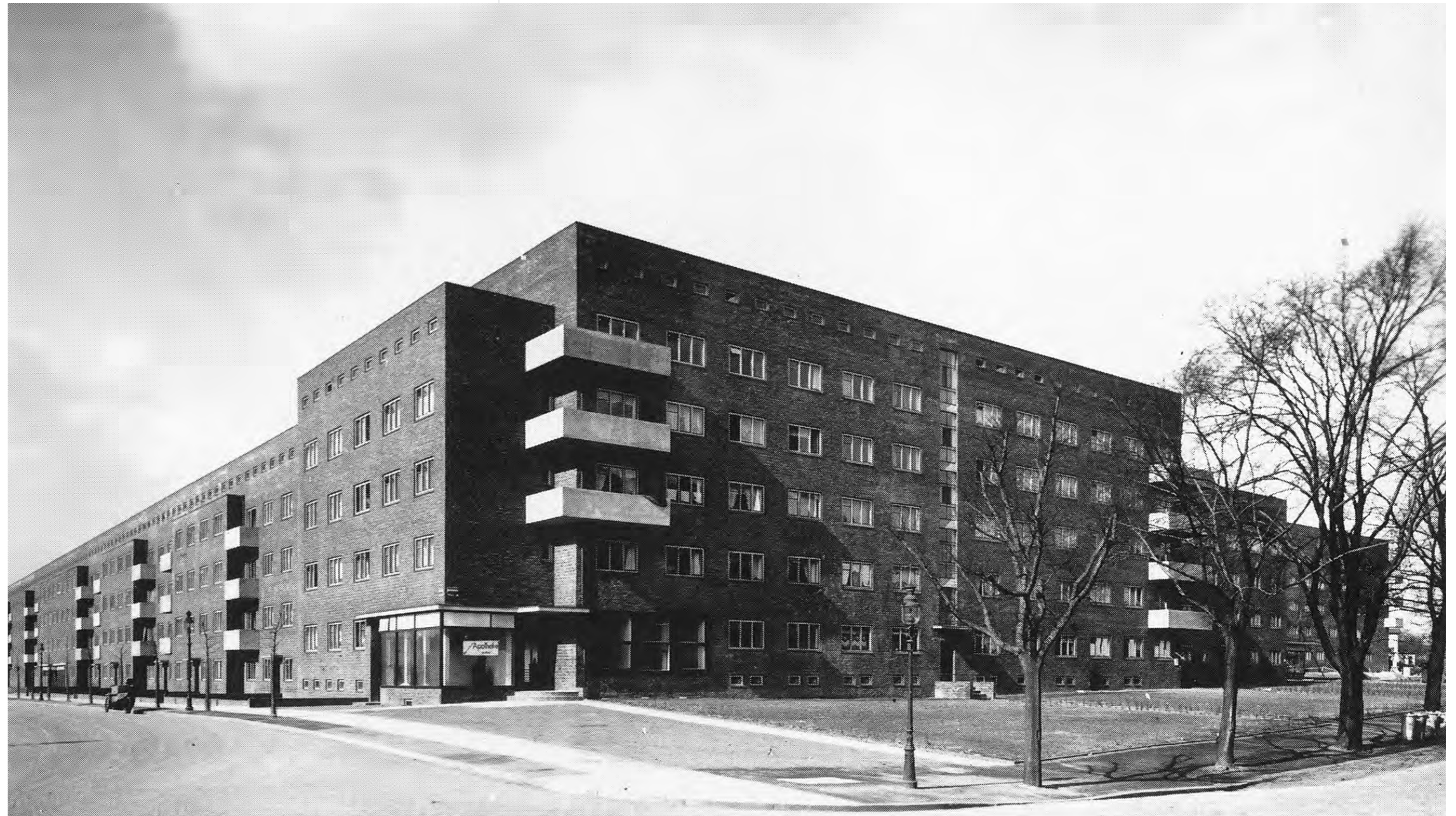
Bild 11: Heidburg– Ecke Poßmoorweg/ Barmbeker Straße
