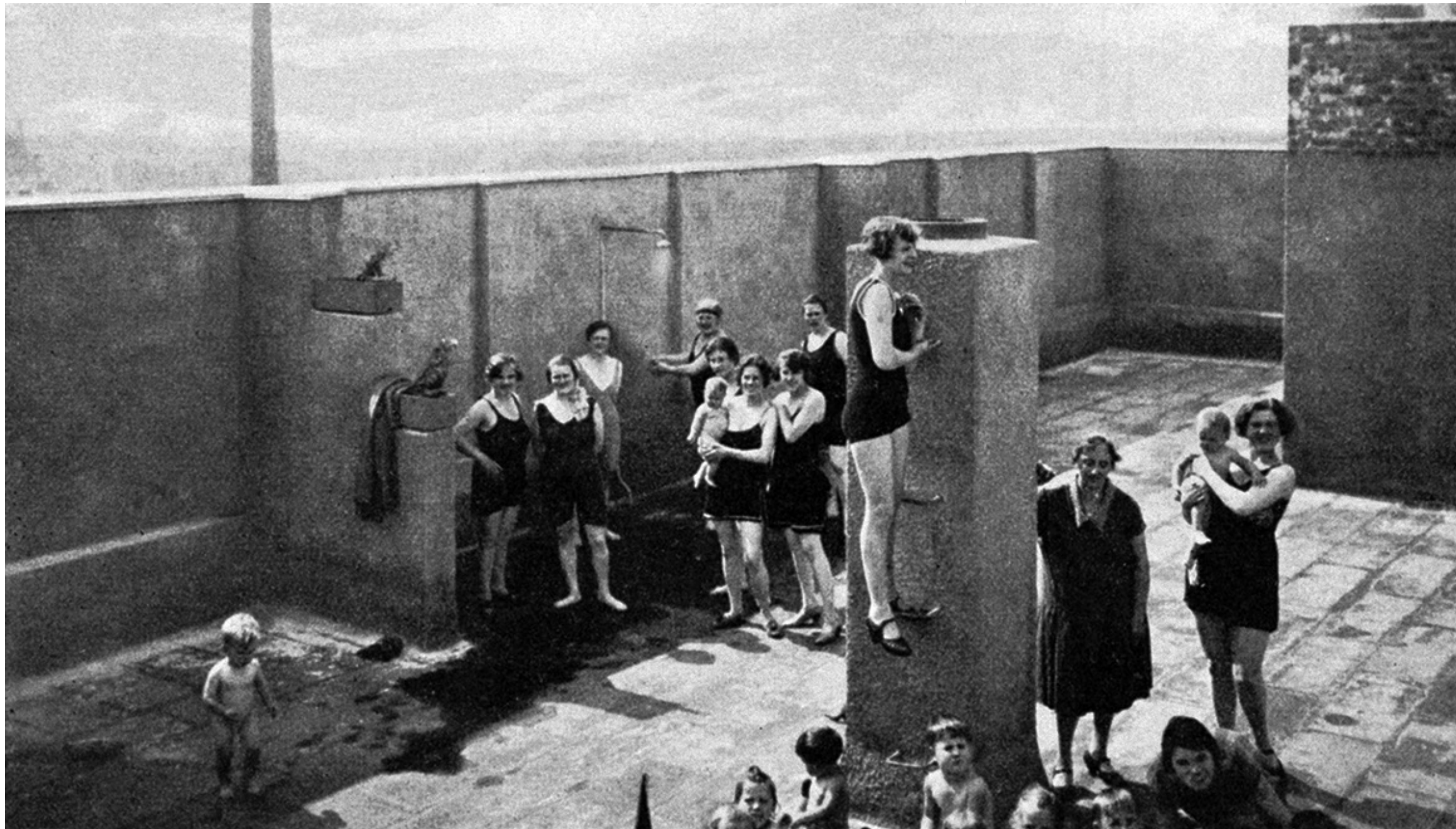
Bild 11: 'Luftbad' Dachgarten des Laubenganghofes am Heidhörn, Arch. Gebrüder Frank, Hamburg 1927
