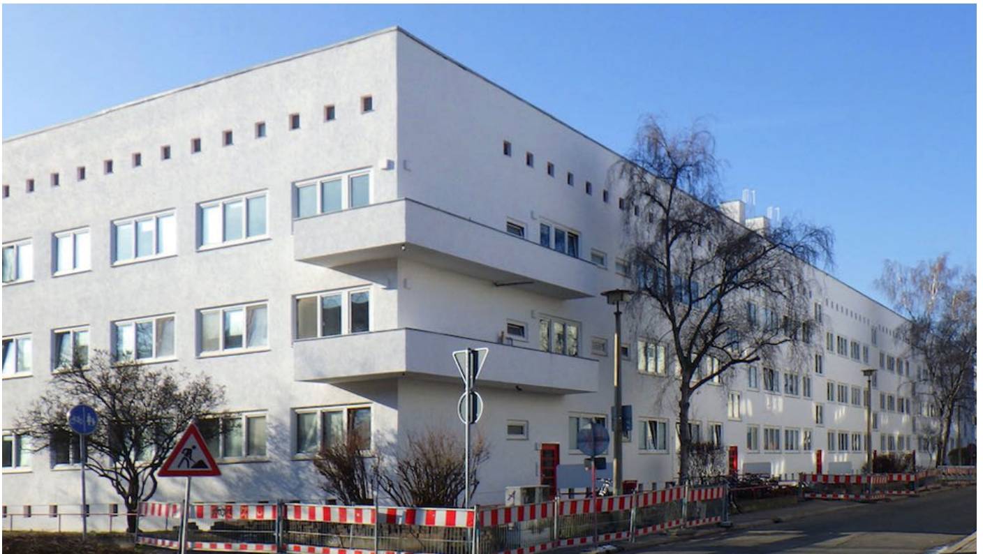
Bild 10: Sanierte Fassaden des Hansa Blockes, Blick von Nordosten
